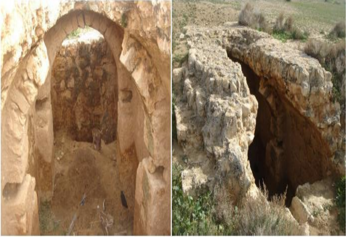
صورة رقم 4: بقايا خزان الماء
