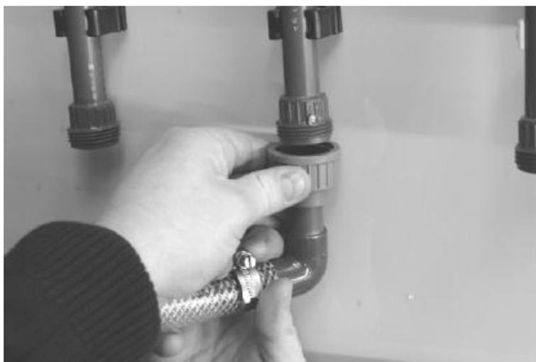
**Figure 07 : Raccord de connection à la section du circuit gris**
