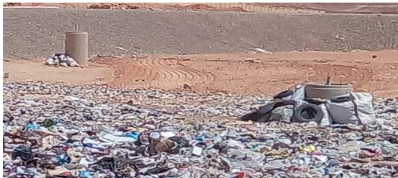
Figure N°14: Tube de sortie de biogaz, CET Metlili (diamètre 1m) distance max 57 m.
