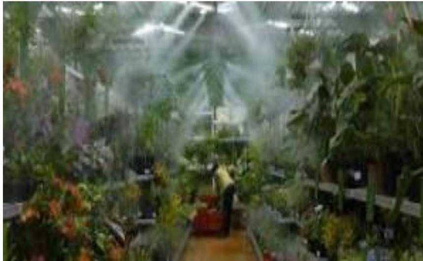
**Figure II-7** : système de brumisation pour pulvériser le brouillard dans l'air
