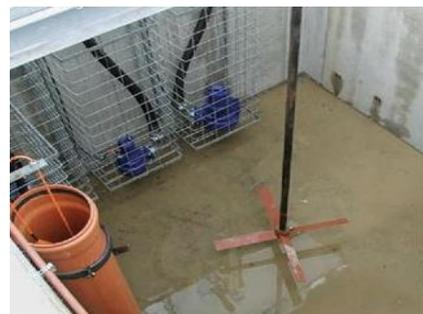
**Figure 1.4 Bassin d'homogénéisation avec agitateurs et pompes**
