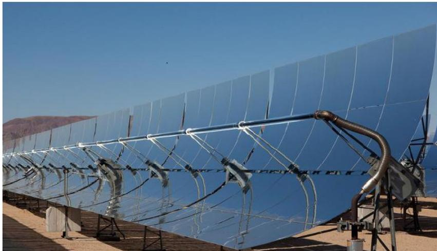
**Figure I.8 :** Capteur solaire thermique cylindro-parabolique [15]
