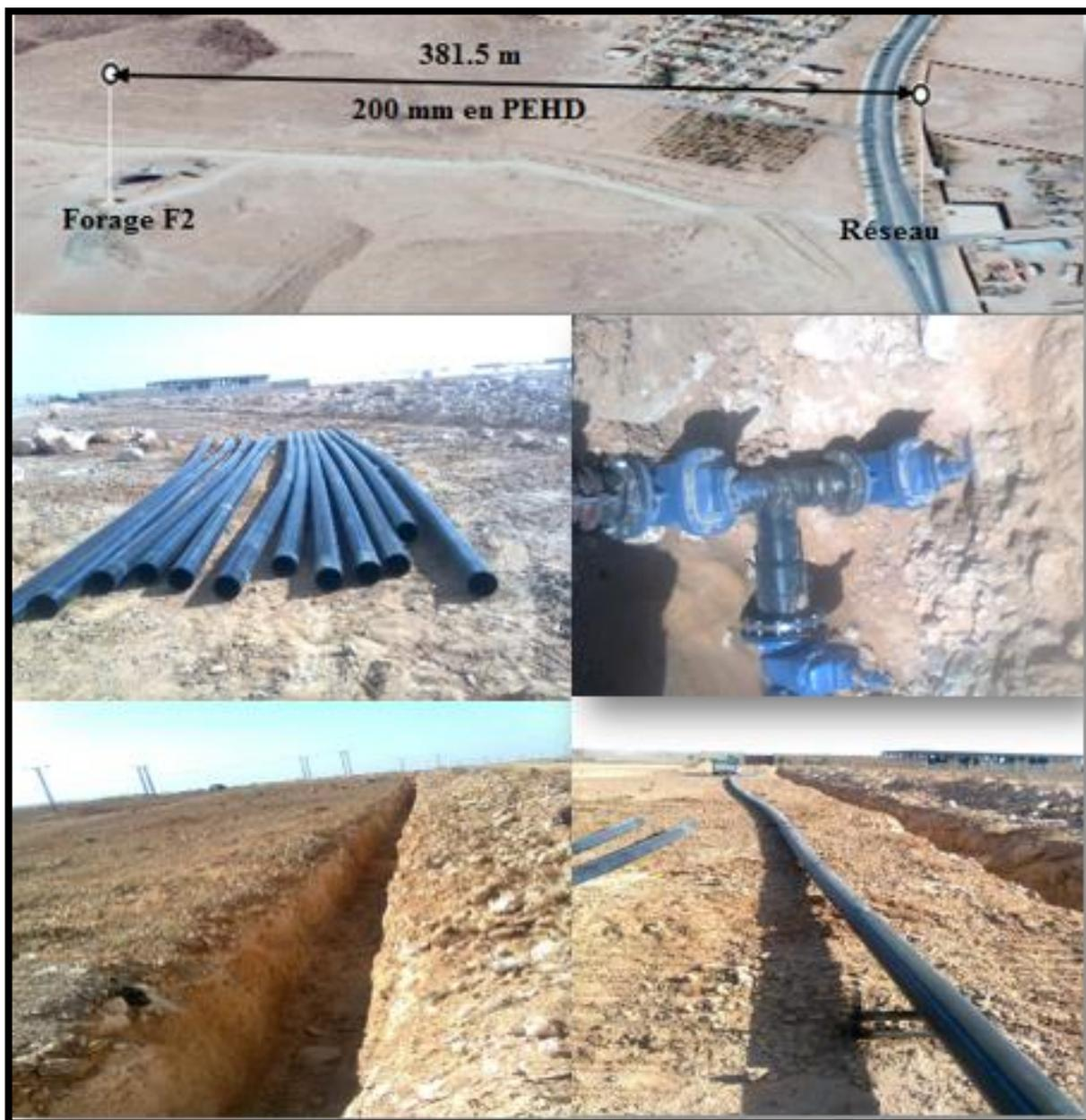
*Figure N°III.4 : Adduction du forage F<sub>2</sub> vers le réseau avec ces accessoires.*
