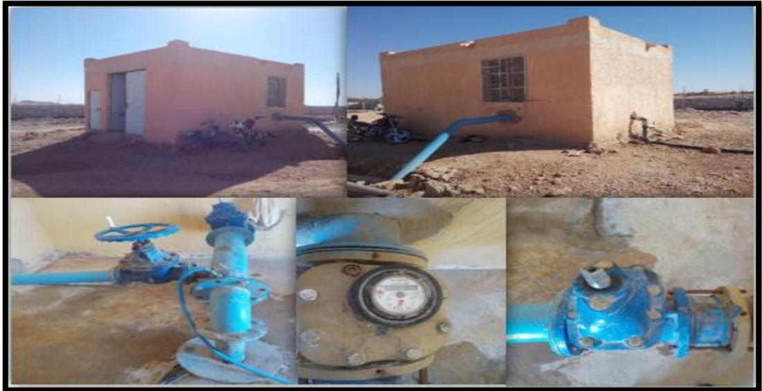
***Figure N°III.2 : Forage F2 avec ces accessoires.***
