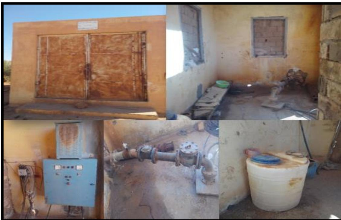
**Figure N°III.1 : Forage F1 avec ces accessoires.**
