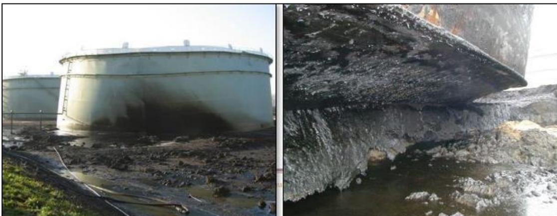
**Figure I.18 :** Ouverture d'un fond de bac par corrosion interne [8,9]
