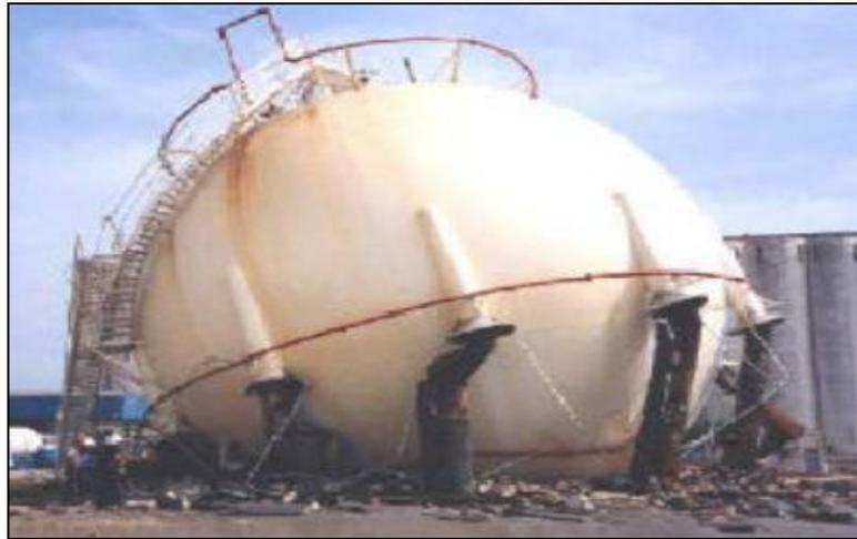
**Figure I.19** : Affaiblissement par corrosion sous protection anti-feu
