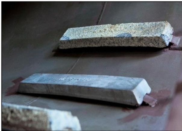
**Figure II.5 :** Anodes sacrificielles
