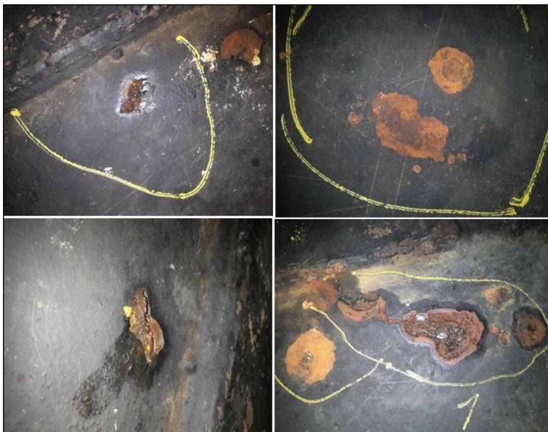
*Figure IV.2* : L'effet de la corrosion interne au niveau de bac **R3**
