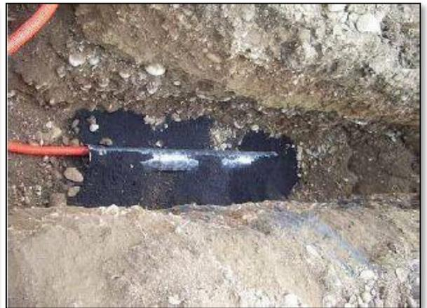
**Figure II.6:** Pose d'une anode prébackfillée
