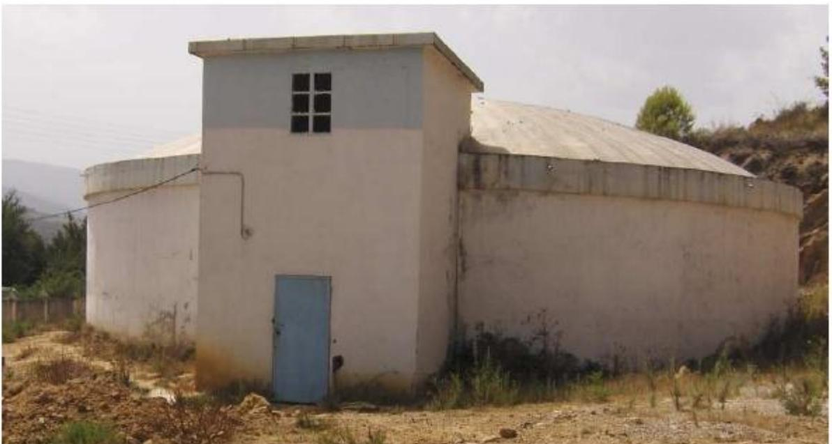
**Figure 8:** Réservoir circulaire posé au sol en béton armé (hammoum 2012) (Nassima .M, 2014).
