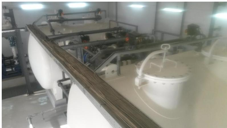
**Figure 19 : les filtres à sable de la station de GHARBOUZ**
