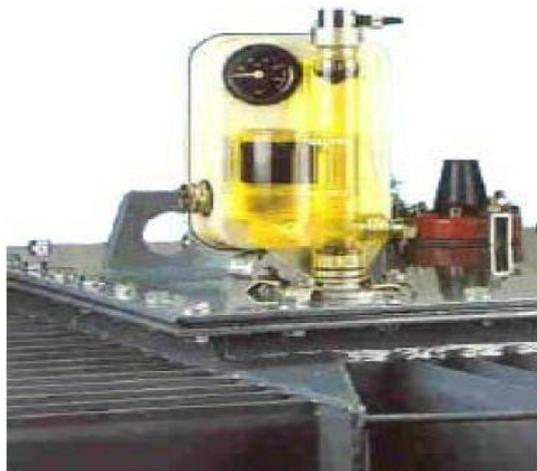
*Figure II-19: Schéma de dispositif DGPT*
