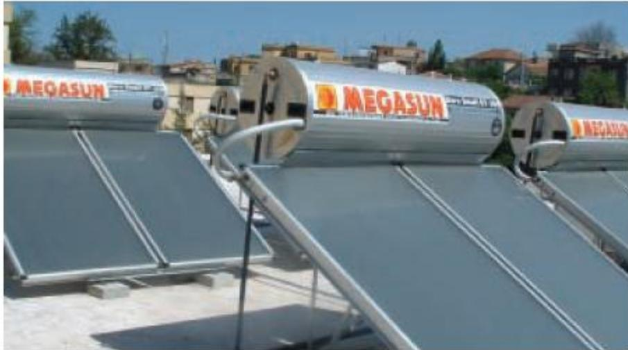
Figure II.3 : La production d'eau chaude sanitaire
