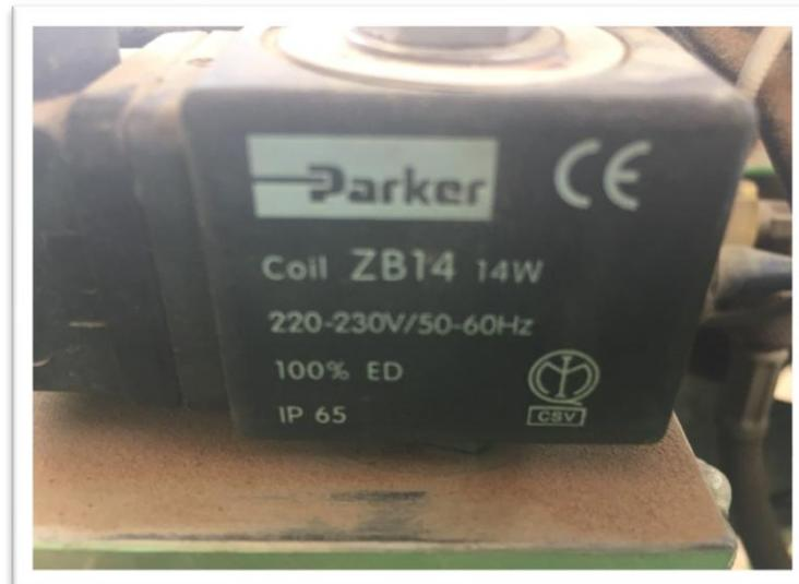
*Figure 27: Bobine d'une électrovanne 14 W*
