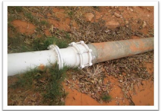
Photo N°6.11. Raccordement amiante-ciment et PEHD
