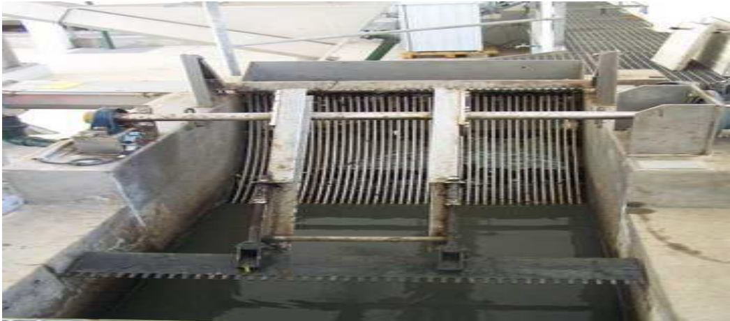
Photo 02 : Dégrilleur courbe
