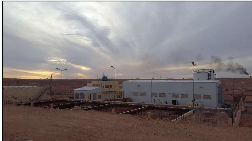
Figure II.8 : Unité de déshuilage ONR de capacité 500 m<sup>3</sup>/j [17]
