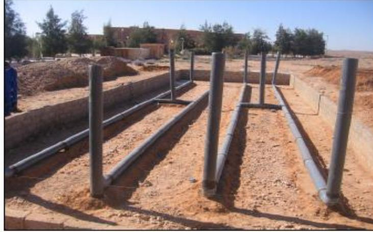
Fig.5 : Système de stockage placé sous serre
