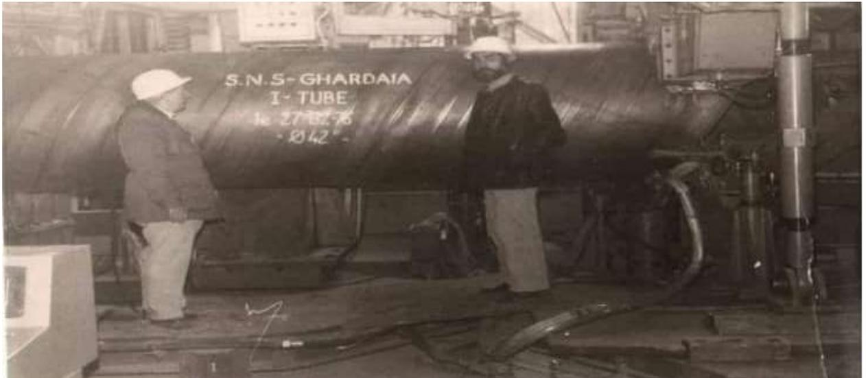
Figure III.1 : Le premier tube produit par la machine à souder spirale
