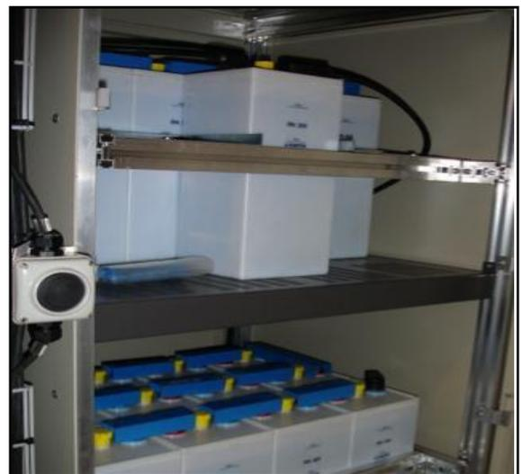
Figure III.14 : L'armoire des batteries 24 VDC. [18]
