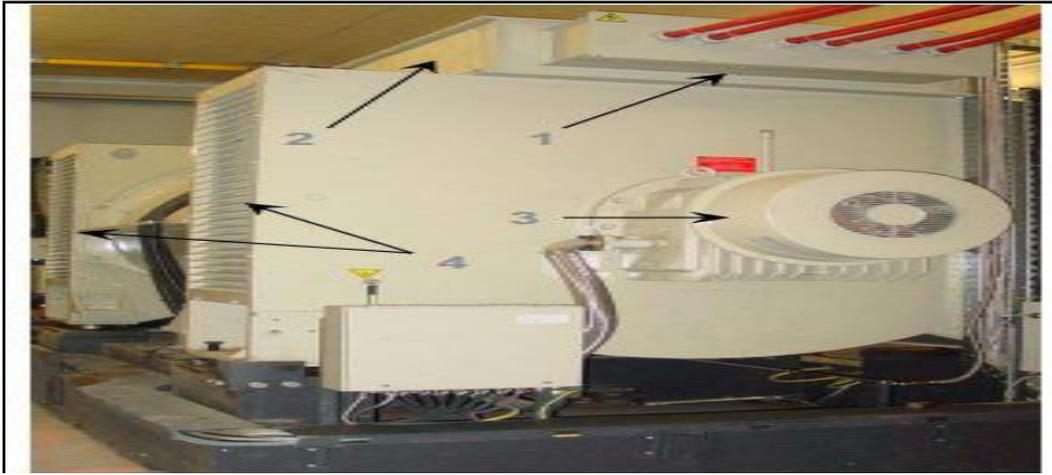
Figure III.8 : Vue extérieure de L'alternateur TURBOMACH T70.[18]
