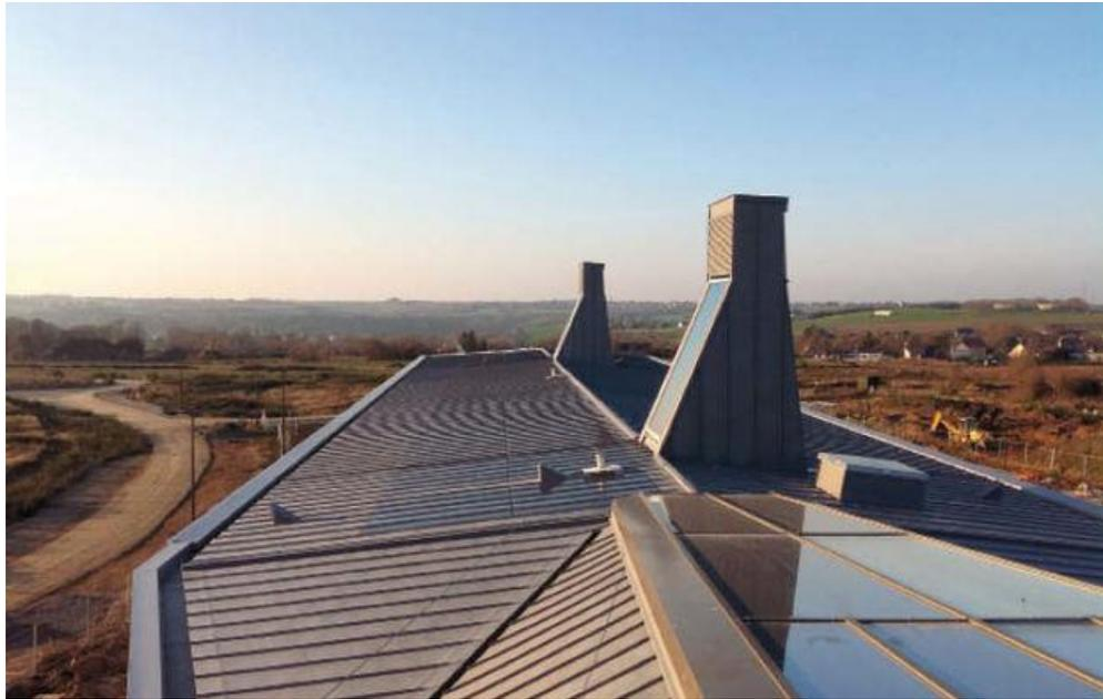
Figure (I.5) : Exemple de cheminée solaire intégré sur le bâtiment [13].
