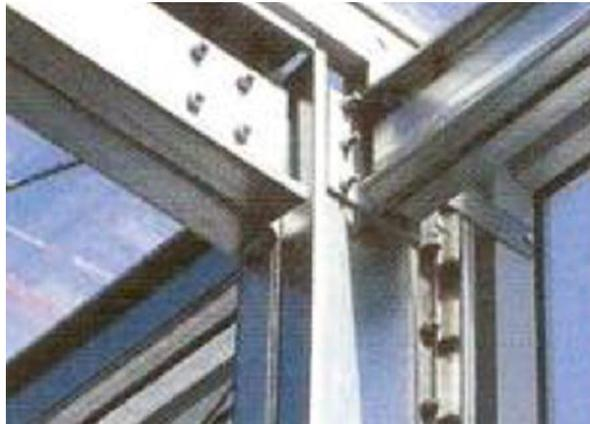
Fig.50 : Assemblage mécanique par boulons
