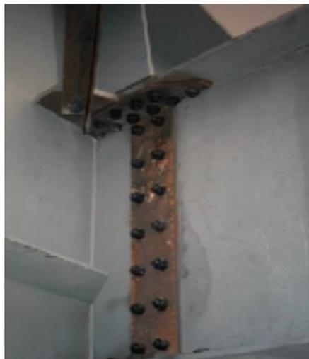
**Fig.47 :** Le raboutage des tronçons avec boulonnage
