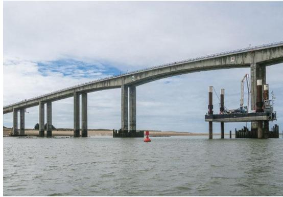
**Fig.37** : Piles de type poteaux
