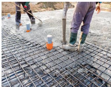
Fig.09 : Coulage d'une dalle
