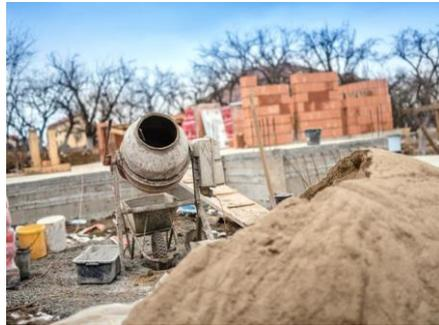
Fig.7: Malaxage du béton par bétonnière
