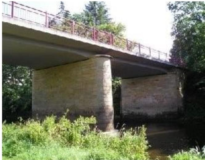
**Fig.73** : Pont à dalle précontraint
