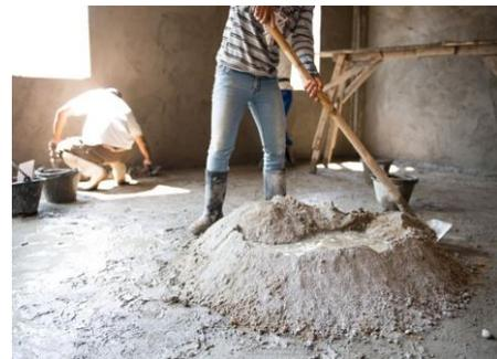
Fig.8: Malaxage manuel du béton
