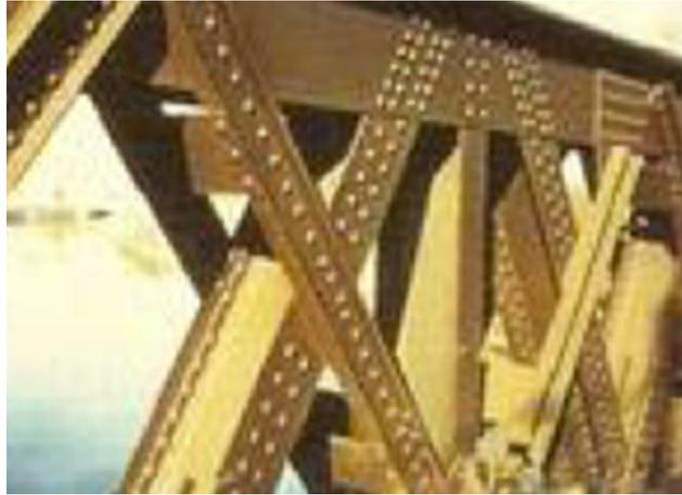
**Fig.51** : Assemblage mécanique par les Rivers
