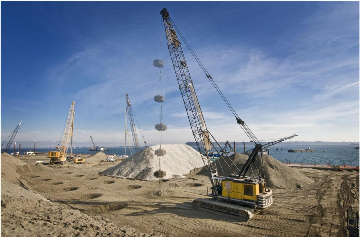
Photo I.1 : Chantier d'un compactage dynamique profond [19].
