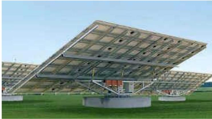
Fig. II.13: Suiveur à axe verticale incliné.
