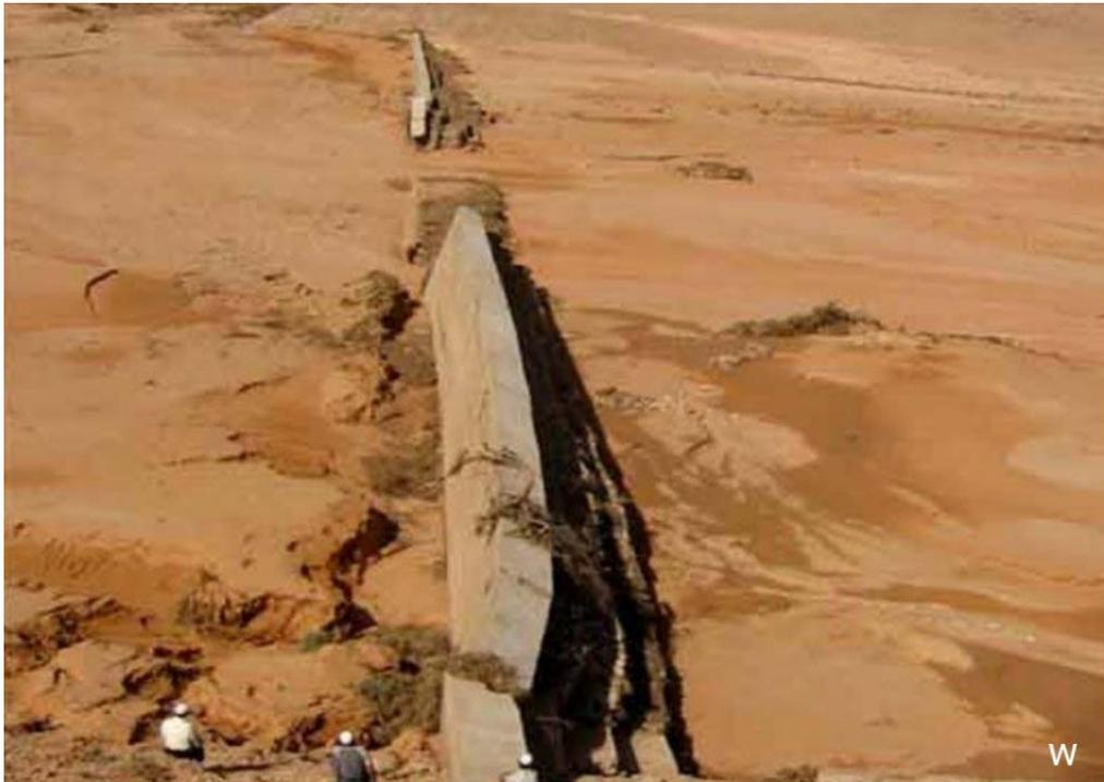
**Figure 22** : Photo de la digue détruite du barrage d'El Haimeur
