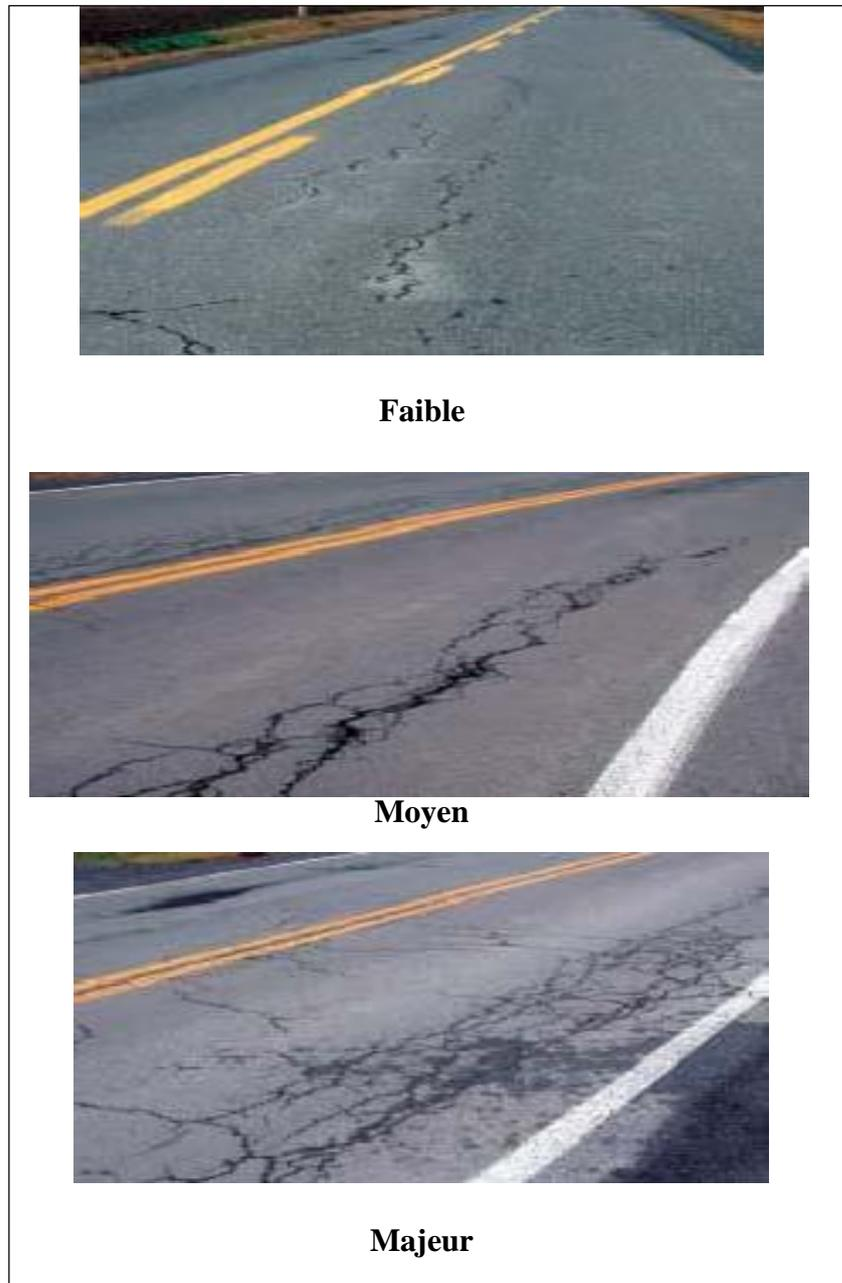
**(Figure II.05) :** Les fissurations longitudinales
