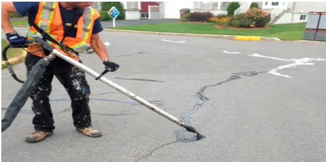
(Figure IV.5) : Les Réparations des Fissures
