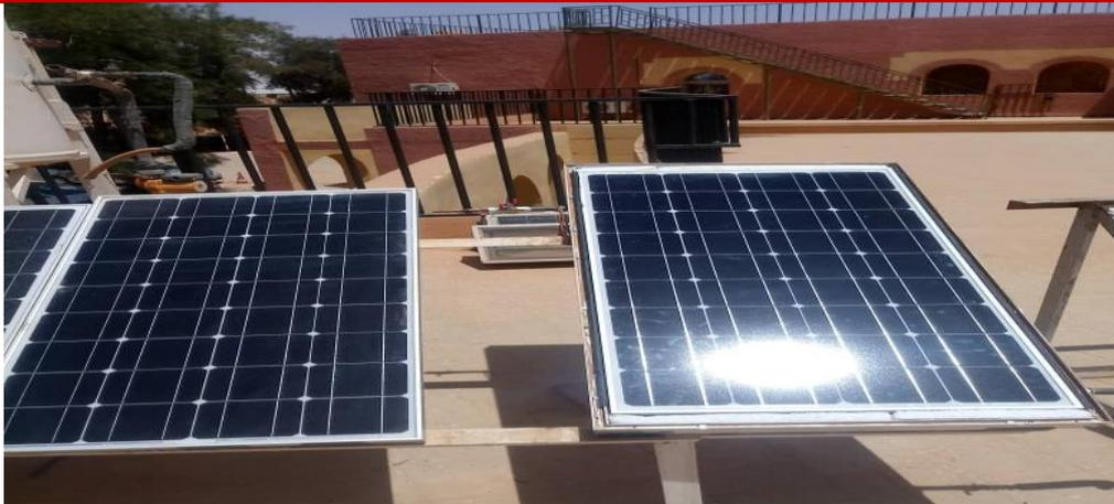
**Figure IV.9** Le capteur hybride PV et PVT à eau
