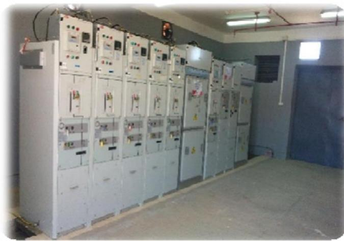
**Figure I. 14.** Poste d'évacuation moyen tension – HTA
