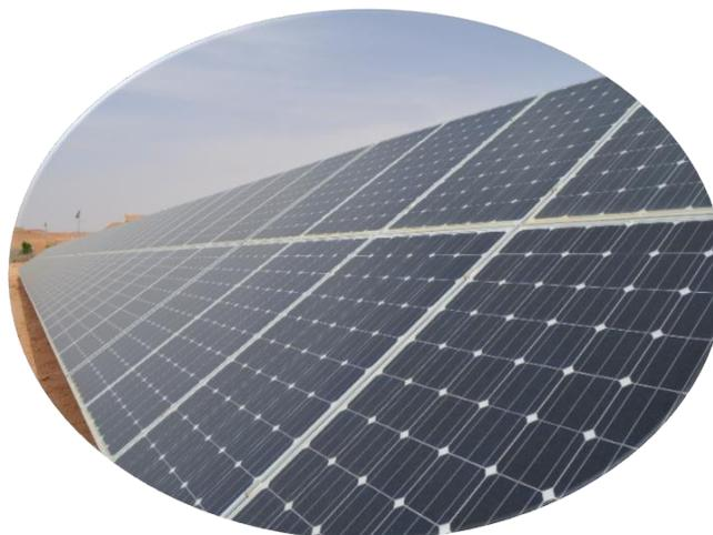
**Figure I. 4.** Panneaux en silicium monocristallin
