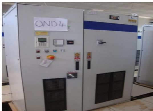
Figure I. 11. Onduleur de central PV Ghardaïa
