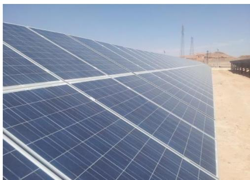
**Figure I. 5.** Panneaux en silicium polycristallin
