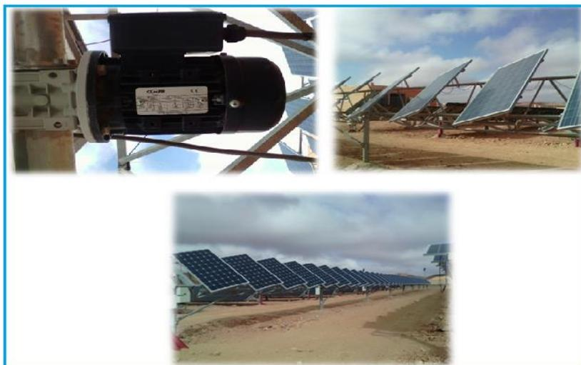
**Figure I. 7.** Modules photovoltaïques motorisée [mono/poly] et le moteur de motorisation
