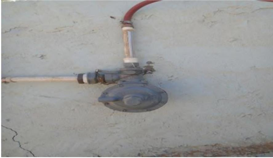
**Régulateur gaz (détendeur) utilisé.**
