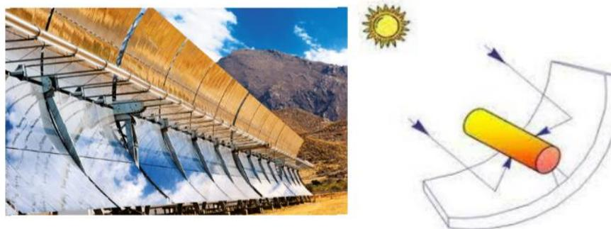
Figure I.9 : Système à collecteurs cylindro-paraboliques.
