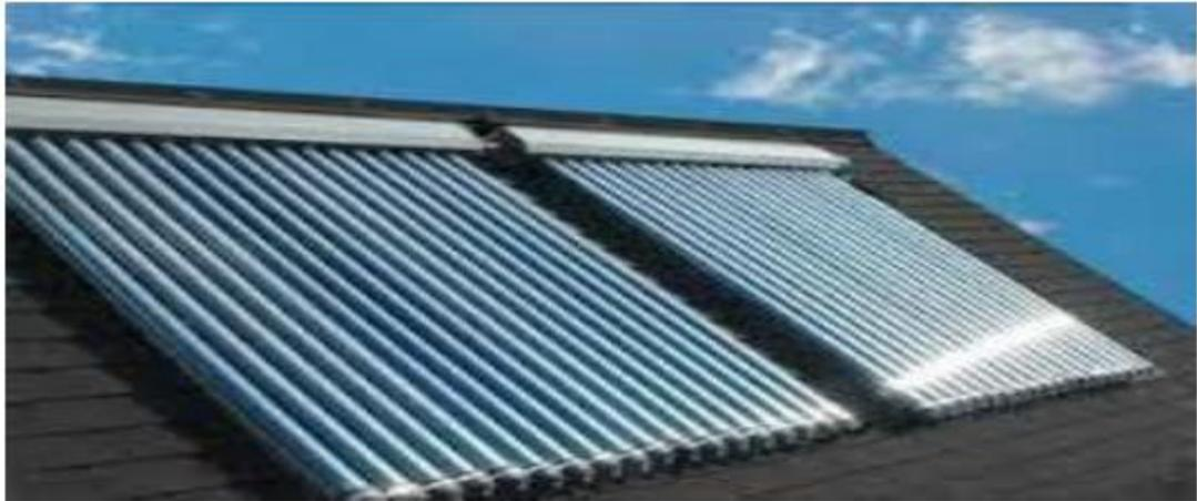
Figure II.6 : Capteur sous vide
