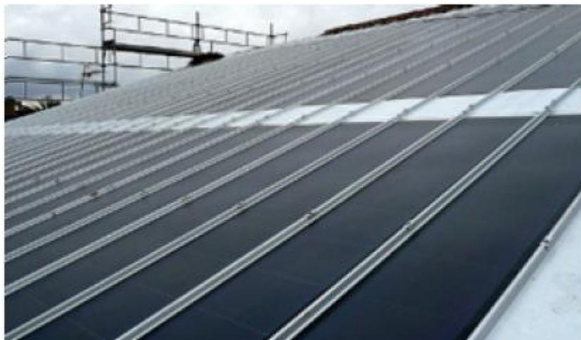
**Figure II.3 :** Vu d'un capteur solaire non vitré
